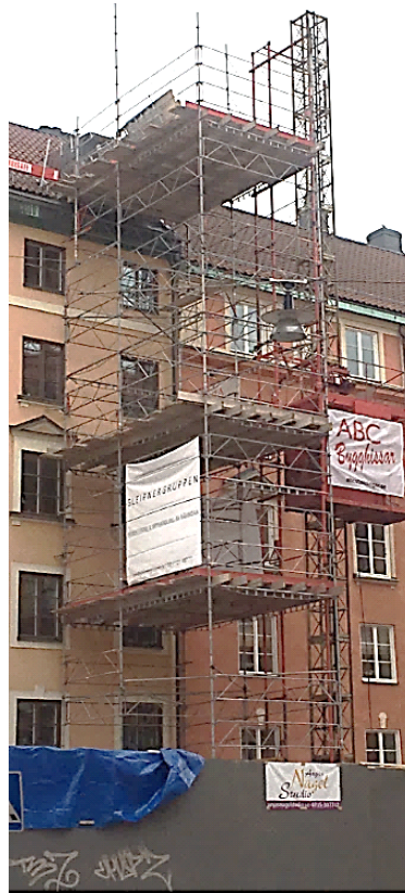
Bygghiss placerad på gatan framför fasaden
